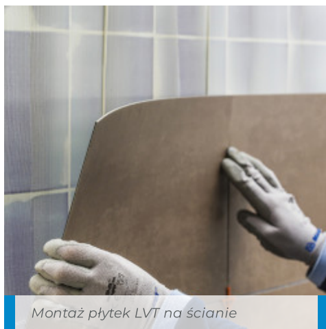
Układanie LVT na podłozie za pomocą Ultrabond Eco MS 4LVT Wall&Floor w pomieszczeniu mokrym
