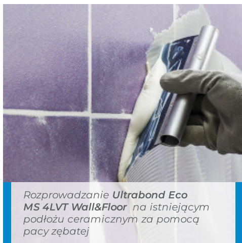
Montaż płytek LVT na ścianie
